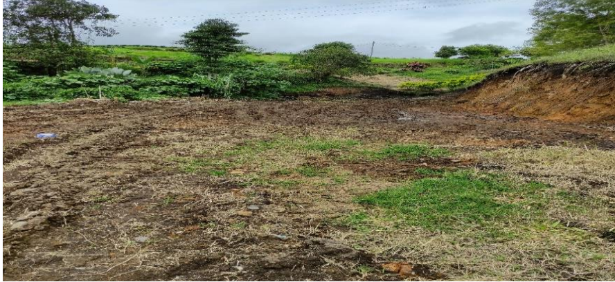
Foto 2. descripción: Lote en explanación lugar para instalar Tableros
